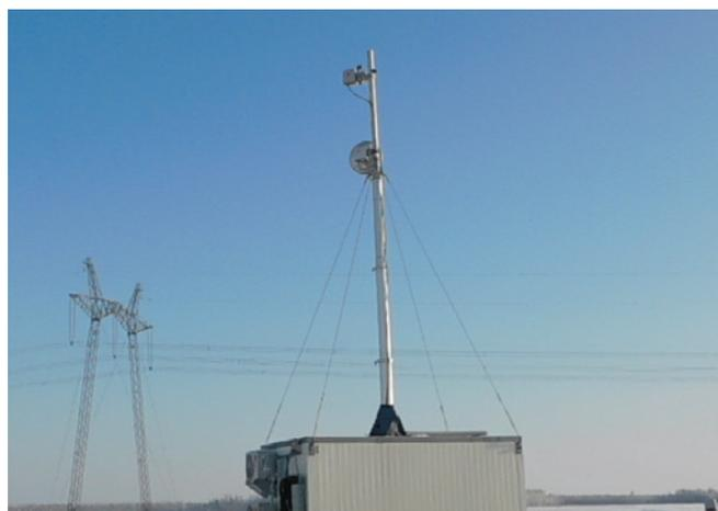
**Рисунок 4 – Размещение PPC 7 ГГц и 38 ГГц на местности**
