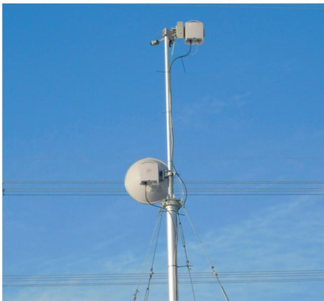
**Рисунок 3 – Размещение антенн PPC 7 ГГц (ниже) и 38 ГГц на мачте**
